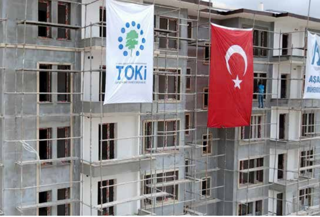
Nurdağı'nda 26 blok halinde inşa edilen kalıcı konutların kaba inşaatları hızla tamamlandı
