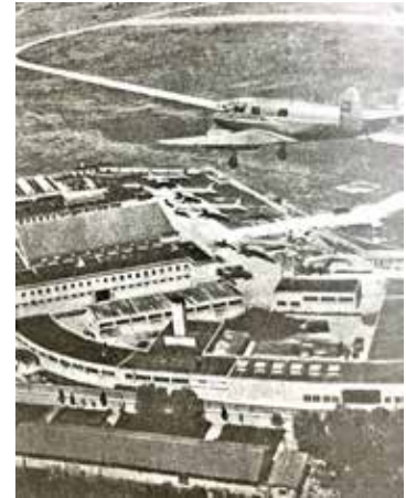
Etimesgut Uçak Fabrikası
