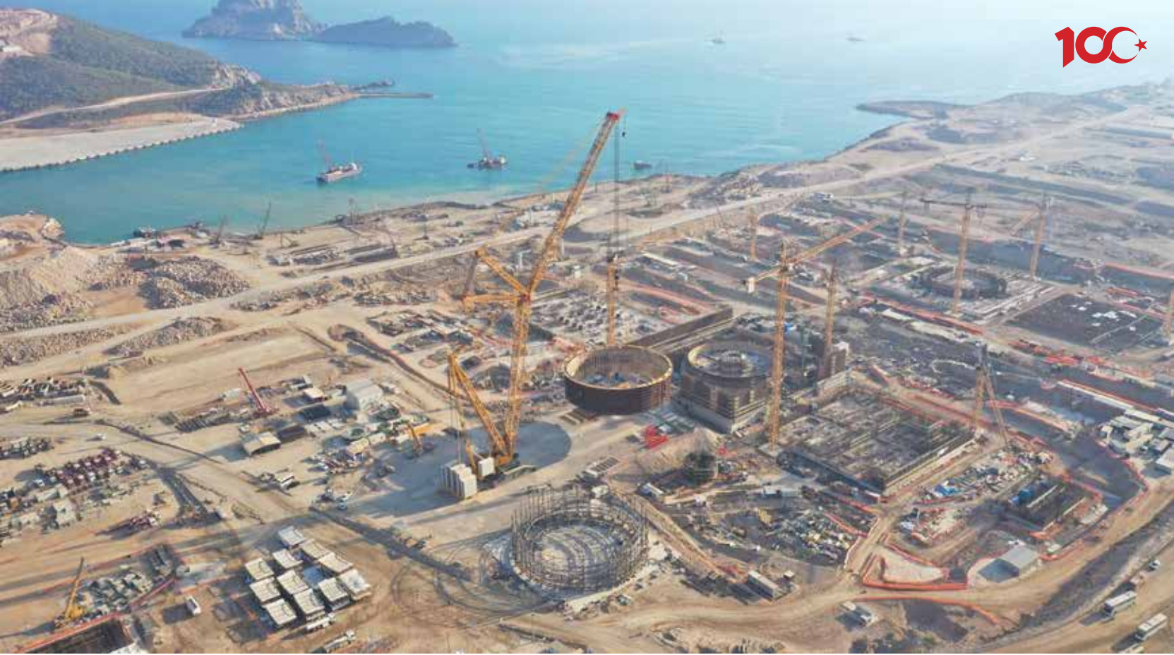
Akkuyu Nükleer Güç Santrali (NGS) inşaatı sürüyor
